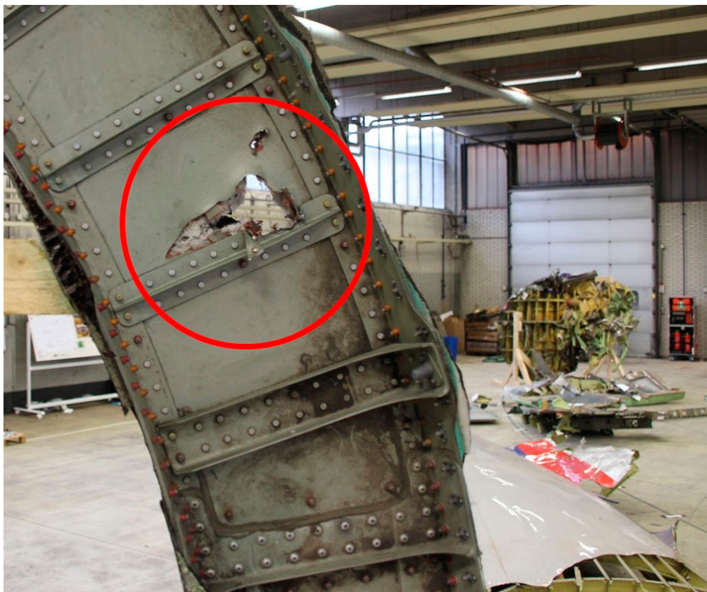
Figuur 29: Inslagschade aan de achterzijde van de ring van de motorgondel
