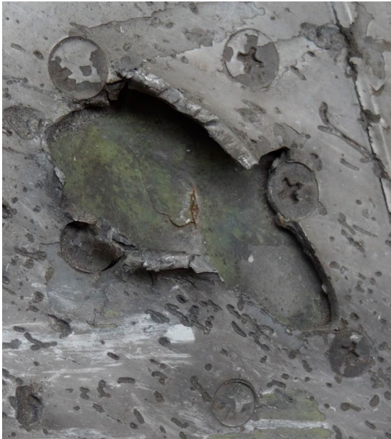
Figuur 9: Doorboring van de buitenste laag
