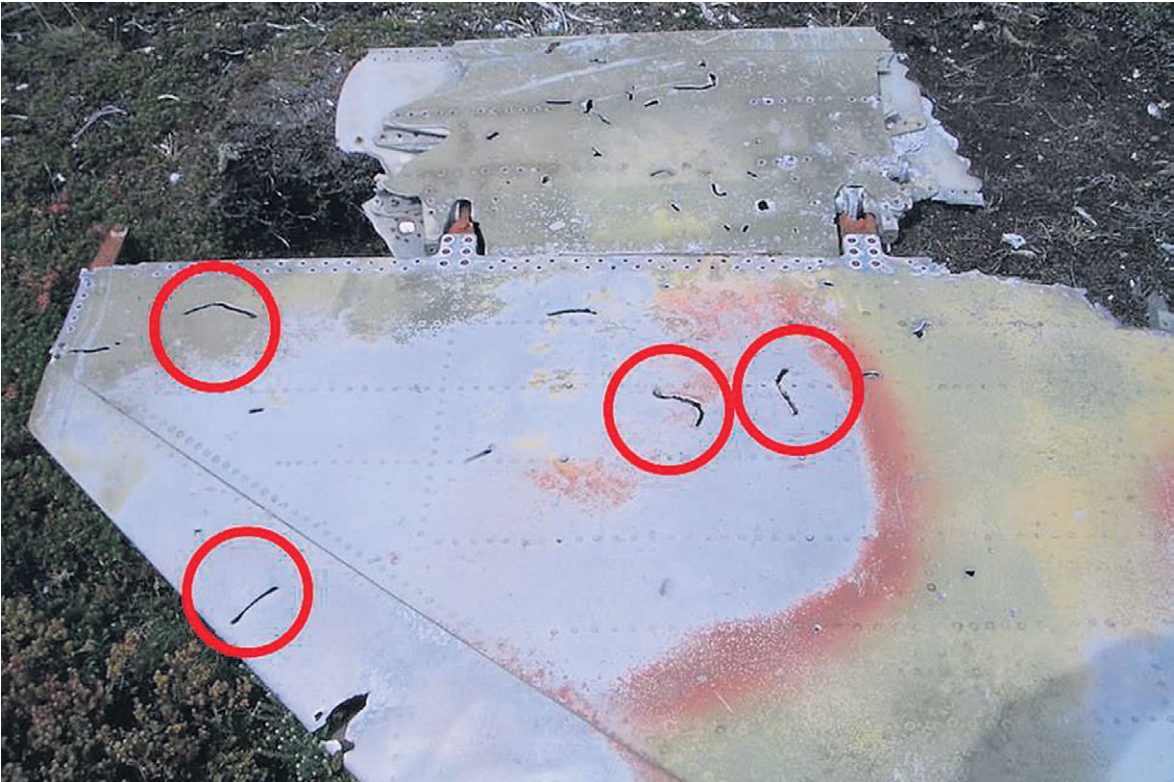
Figuur 52: Voorbeeld van schade veroorzaakt door raketkoppen met metalen staven. (Bron: PPRuNe, via NLR)
